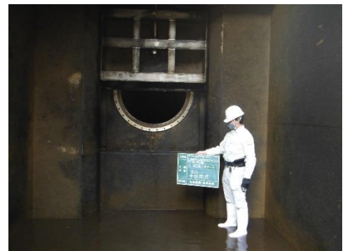
野洲川ダム取水設備・放流設備 点検整備業務委託
